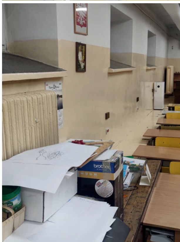
Sala 005 przed remontem
