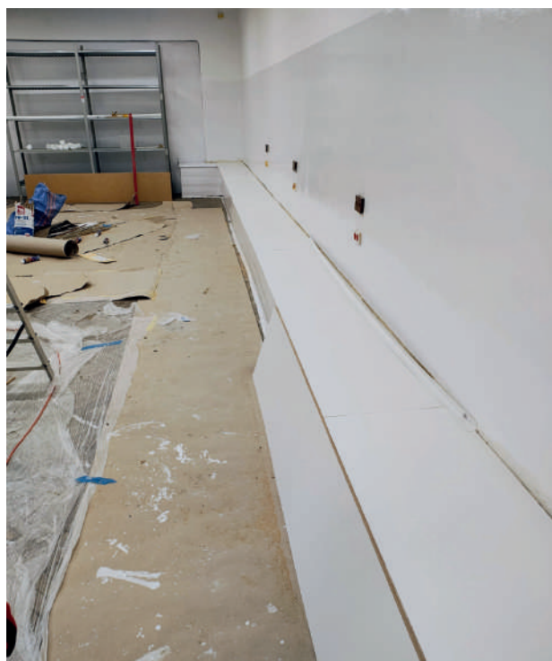
Sala 005 - w trakcie remontu.
